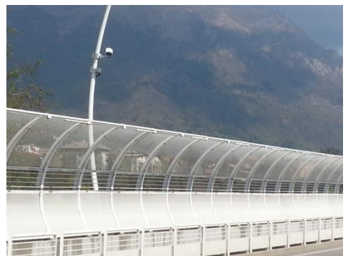
Alcuni sensori ePlate installati sulle direttrici stradali che conducono al Comune di Belluno
